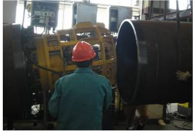
Slika 8. Pozicioniranje cijevi pomoću unutarnje stezaljke Figure 8. Pipes positioning with the help of the pneumatic clamp
