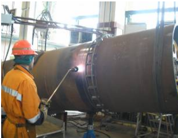
Slika 11. Predgrijavanje cijevi na 100 °C Figure 11. Pipes preheating at the temperature of 100 °C
