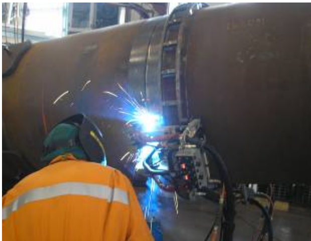
Slika 15. Orbitalno zavarivanje cijevi Figure 15. Orbital pipes welding
